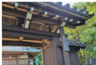
防腐処理後の山門
